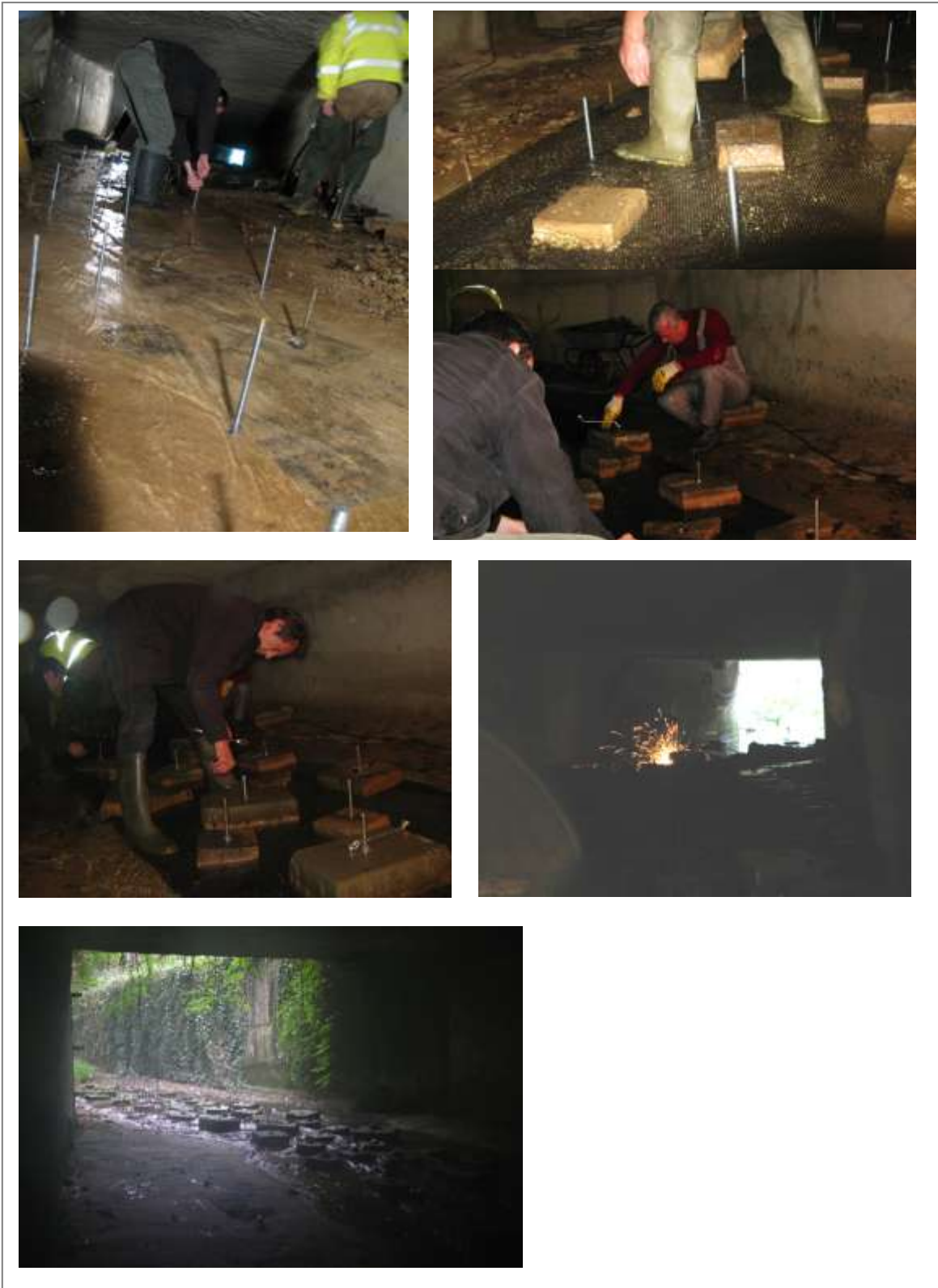
Arbeitsschritte am Erlenbach
