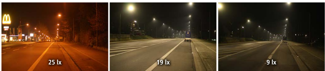
Beleuchtung mit Natriumdampflampen, mit LEDs, und mit auf 50% gedimmten LEDs. Selbst die auf 50% gedimmte LED-Beleuchtung erscheint dem Auge heller als die Natriumdampf-Beleuchtung bei voller Helligkeit.
