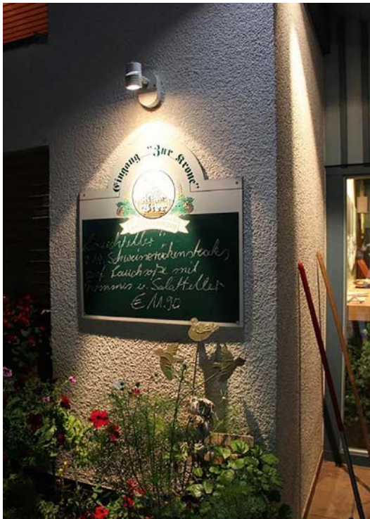
oben: Die nicht abgeschirmte Leuchte gibt das meiste Licht sinnlos nach oben und zur Seite ab.
