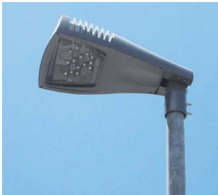
Beispiele für voll abgeschirmte Leuchten.
