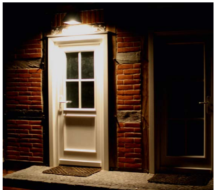
Diese voll abgeschirmten Leuchten leuchten Türzugang und Gehwegfläche gut aus, ohne zu blenden
