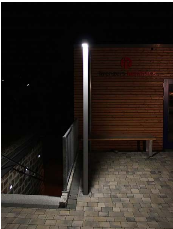
Diese voll abgeschirmten Leuchten leuchten Türzugang und Gehwegfläche gut aus, ohne zu blenden
