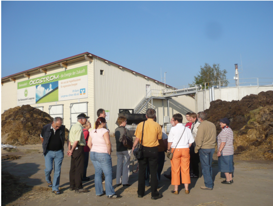
Exkursion zu BAL Biogas-Anlagenbau in Langenau (28.09.2011), Foto: Angela Scheffold
