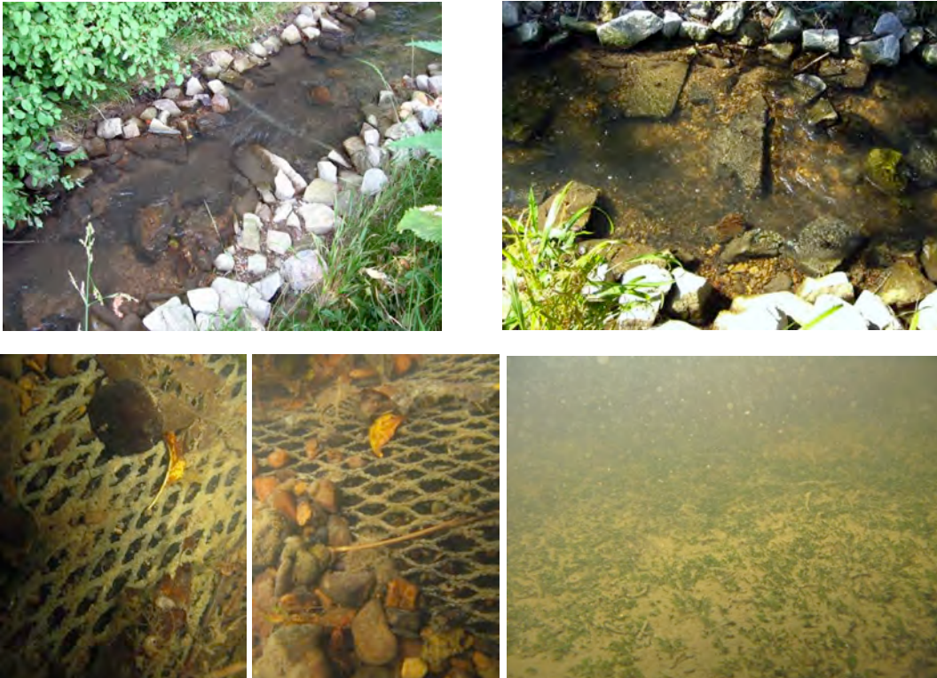
Abbildung 6: Projektbach Reichenbach. Oben von links nach rechts: der zur Beprobung vorgesehene Bachabschnitt, nur noch kleine Bereiche des Textils liegen frei. Unten von links nach rechts: Die meisten
