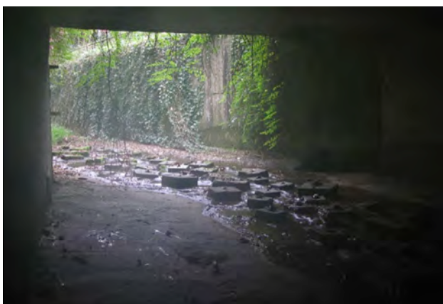
Arbeitsschritte am Erlenbach
